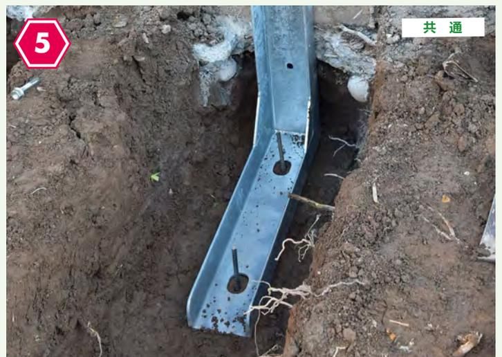
※穴掘り箇所を鉄筋棒などでマークをすると施工が容易です。
