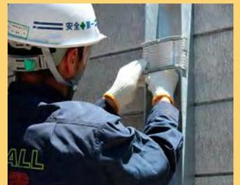
①穴合わせとビスの差し込み ②蝶ナットで締め付け固定
