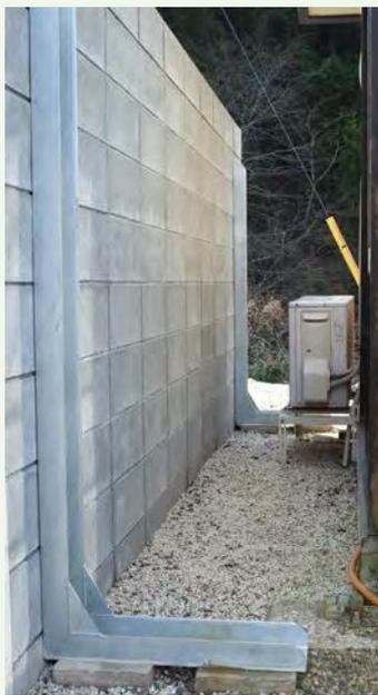
**開発目的** ■震災時にCB塀が瞬間的に転倒するのを防ぎ人命を守る装置
