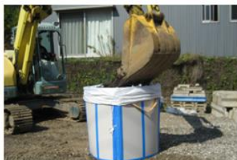
重機で土を入れる
